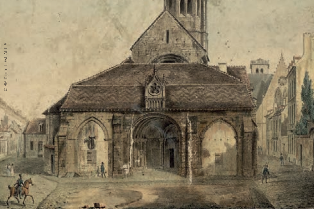
Détail de la toiture du porche de l'église Saint-Philibert, 19 e siècle
